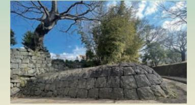
石を川岸に亀の甲羅のように積み上げ、河川の勢いを弱めて川岸を侵食から守るための構造物。加藤清正が治水・土木工事に用いた工法で、小島公園内の旧白川の河川敷に1基残っている。
